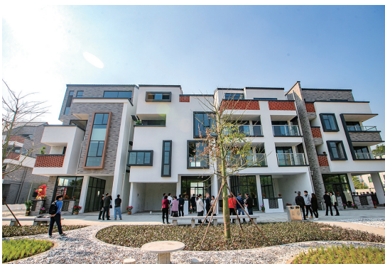
杏坛镇新联村自建房风貌提升示范项目。
