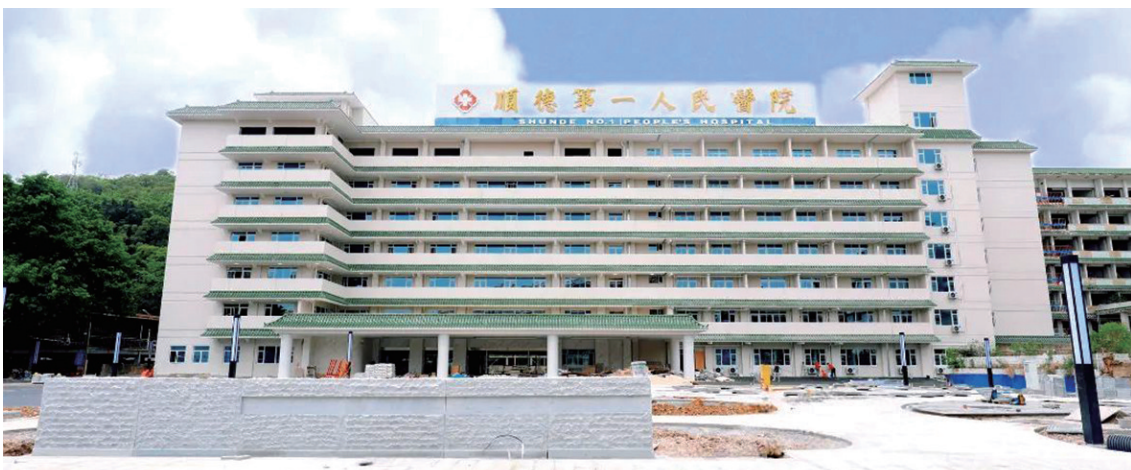
南方医科大学第八附属医院(顺德区第一人民医院)蓬莱路院区焕新工程即将完工。/医院供图
