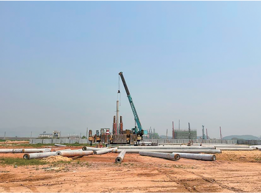
正准航空项目施工现场。
