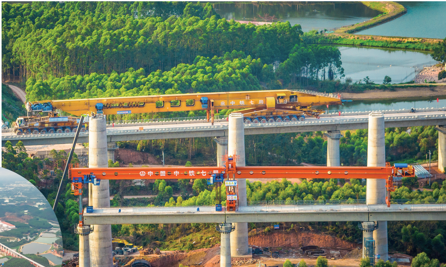
架桥机正在架设箱梁。
