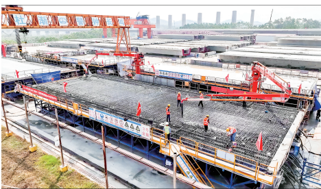
在肇庆制梁场，工人正在浇筑预制箱梁。
