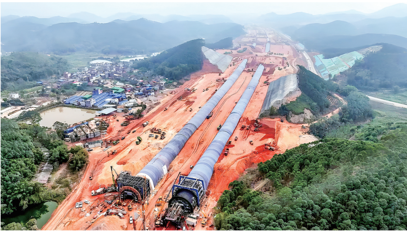
广湛高铁机场1号隧道最后一板衬砌施工顺利完工,土方回填工作正加速推进。
