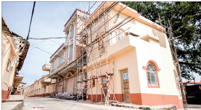
龙头圩重建工程正在收尾阶段。
