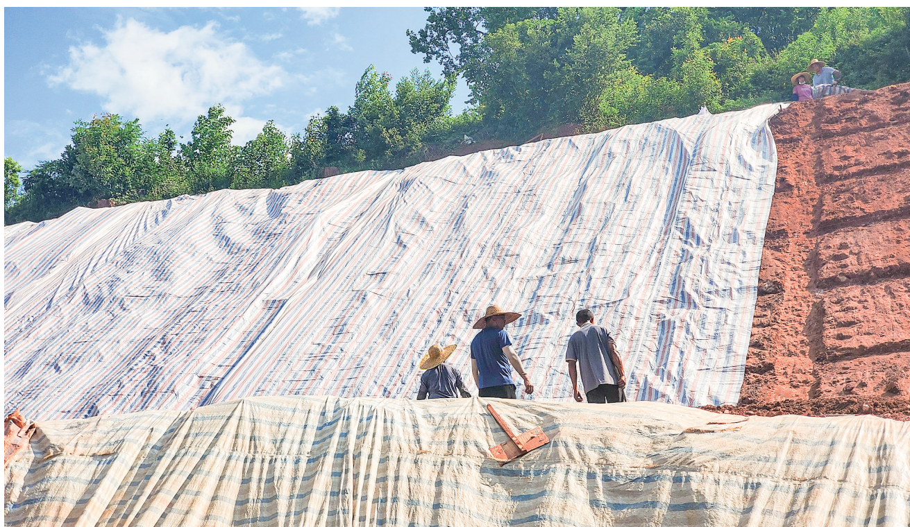
昨日,地质灾害隐患点治理工程工作人员正在往山体上覆盖防水彩条布。/高明融媒记者李祥锐摄
