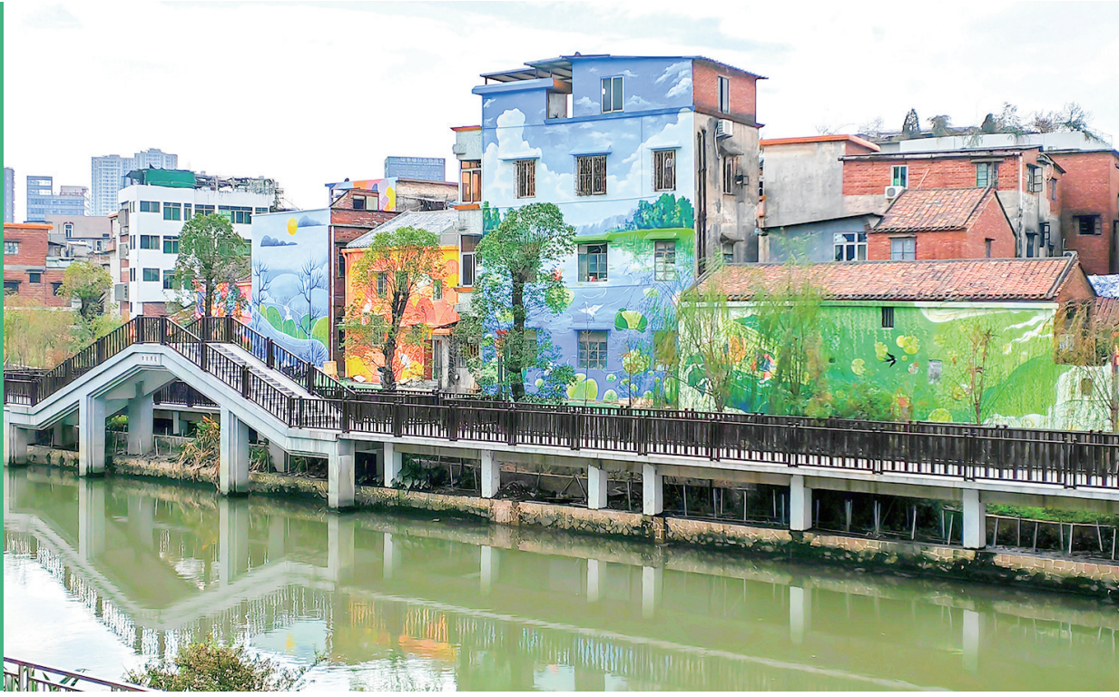
佛山涌(军桥至格沙村段)堤围提升整治项目已基本完工,有效地改善佛山涌的水环境、水经济。/部门供图
