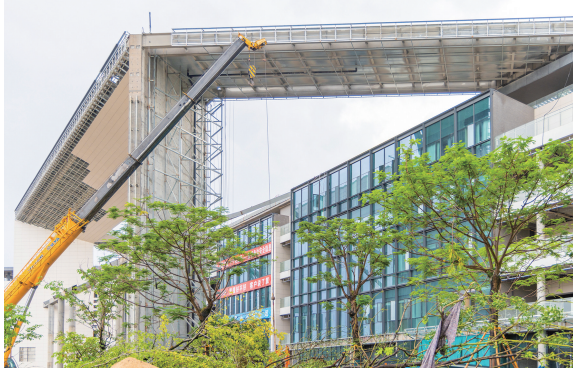
广州中医药大学顺德医院(顺德区中医院)项目开展绿化建设。
