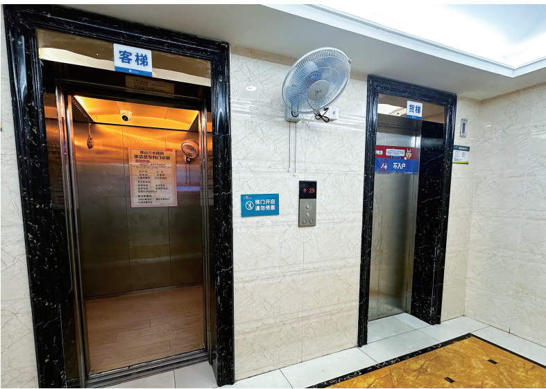
碧桂园三水华府小区的电梯已使用8年,物业近日计划进行维修。
