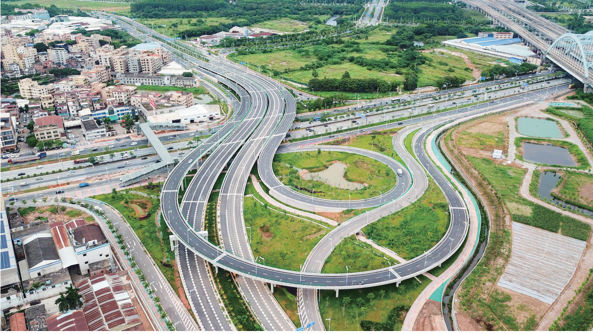
粤桂黔高铁经济带合作试验区(广东园)中线公路工程工贸大道段一期工程。/部门供图
