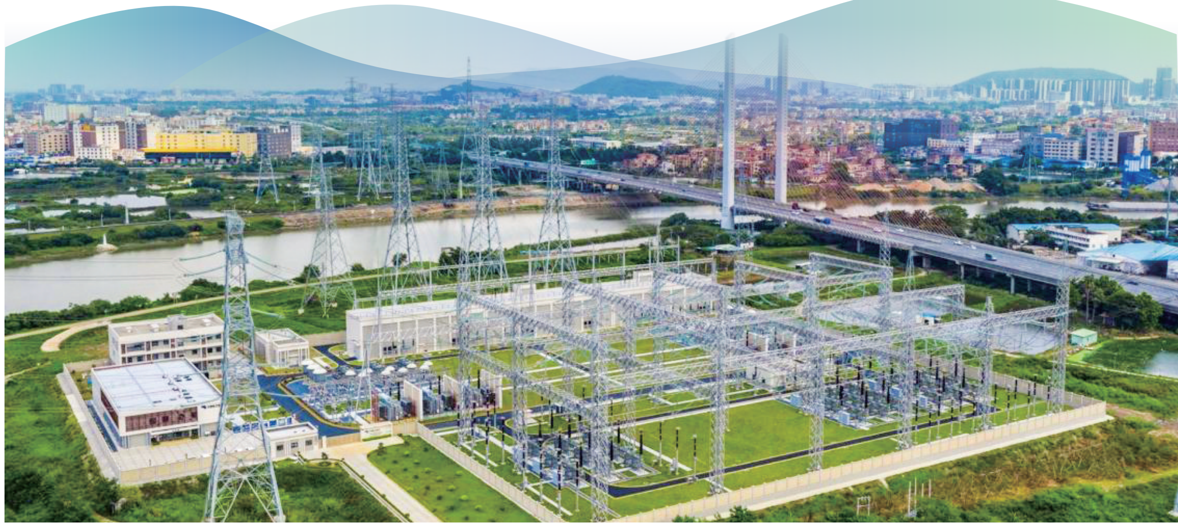
佛山“十五五”电网建设投资计划蓝图正徐徐铺开。图为500千伏凤城站航拍。
