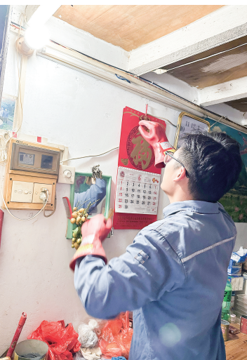
排查小组来到一处居民住宅检测电路安全。
