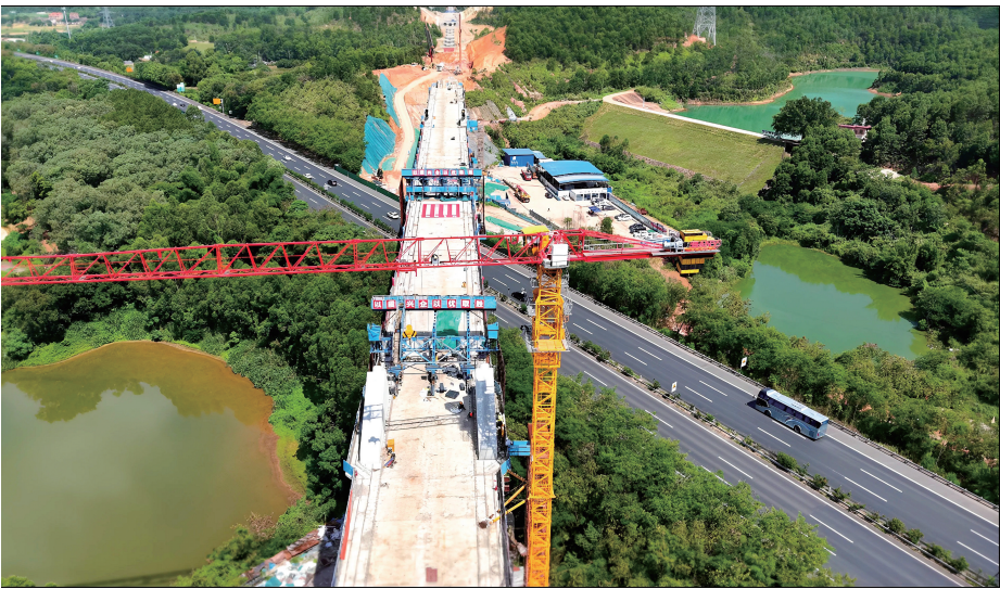
鸟瞰珠肇高铁江机段跨广明高速连续梁拱施工段。
