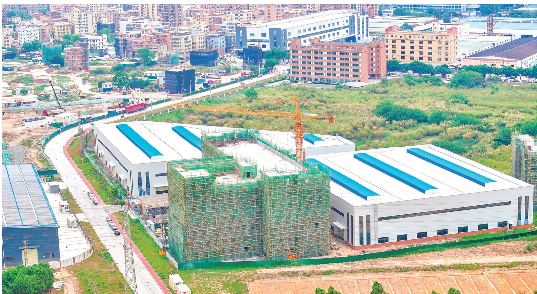
广东尚高电气新能效变压器智造基地。/佛山市新闻传媒中心记者曾锦峰摄
