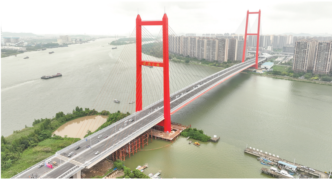
顺德大桥开通首日,车辆有序通行。/佛山市新闻传媒中心记者庞伟杰摄
