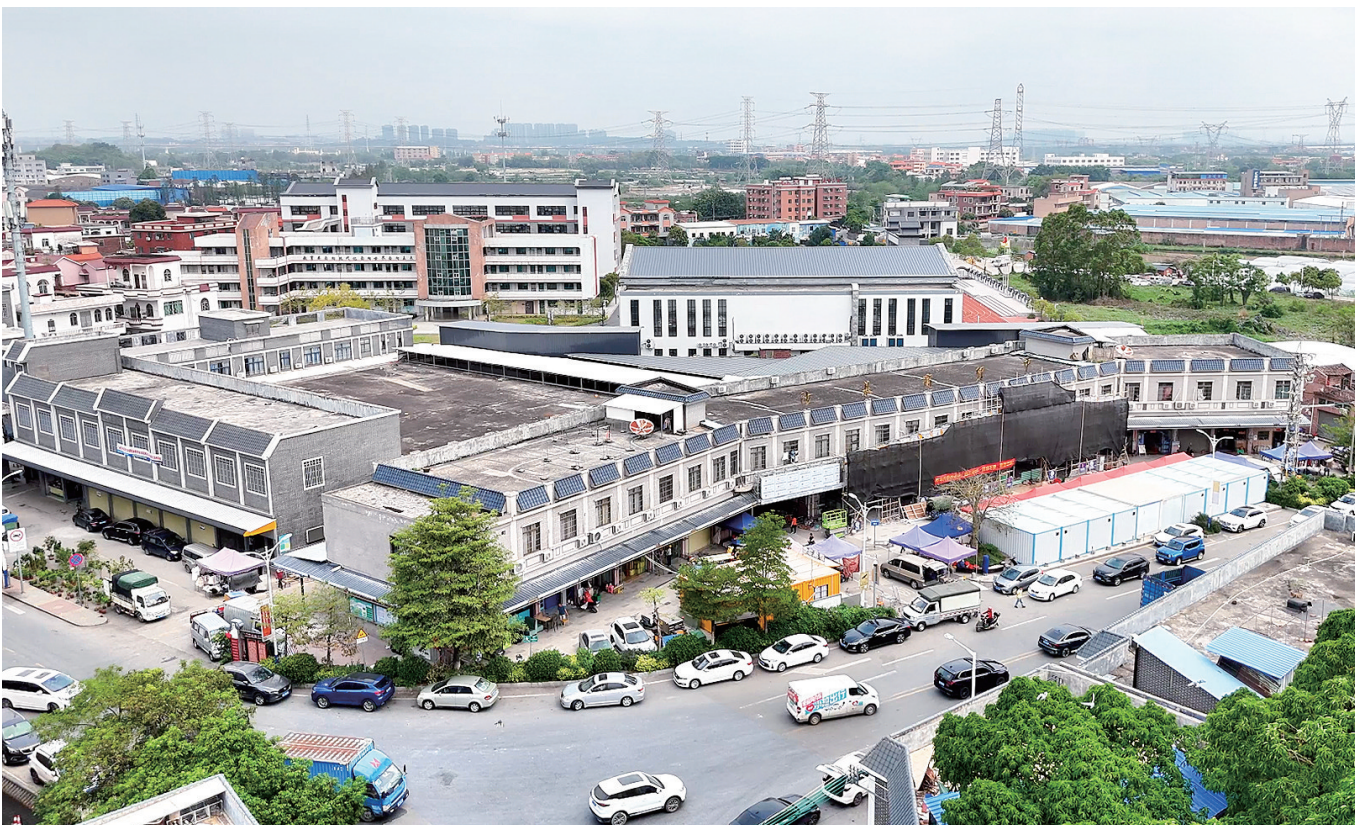
南海区西樵镇上金瓯社区沙基商贸中心项目正在加紧改造施工。/佛山市新闻传媒中心记者关浩业摄
