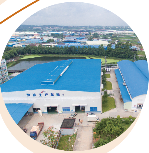
航拍广东盛路通信科技股份有限公司生产车间。该企业在三水增资扩产，积极研发、生产新一代智能通信设备。 /佛山市新闻传媒中心记者黄锦成摄
