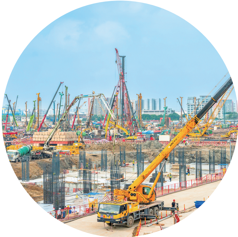
2024年7月,广湛高铁佛山站正式启动建设。图为如火如荼的项目施工现场。/佛山市新闻传媒中心记者王澍摄
