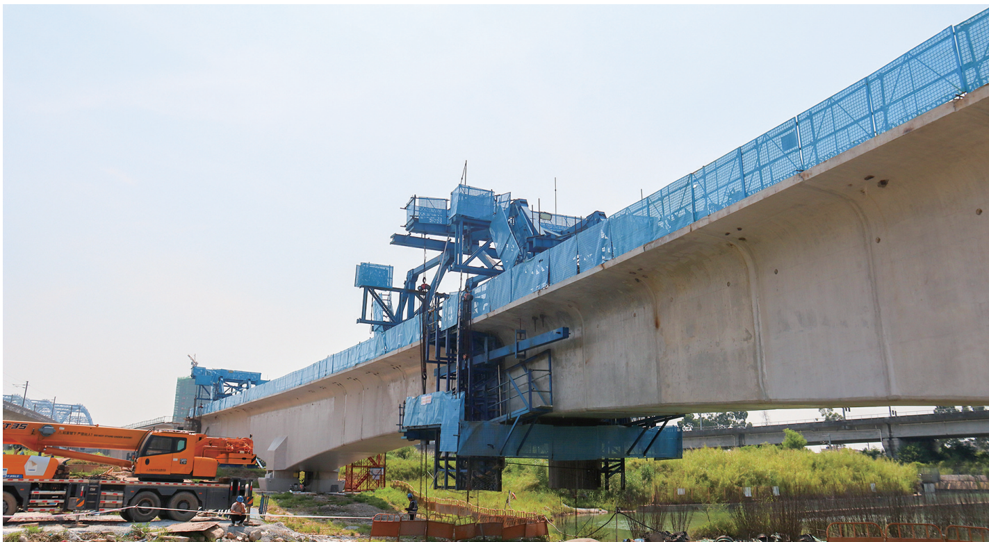
广佛西环白沙桥特大桥连续梁首跨顺利合龙。/通讯员供图
