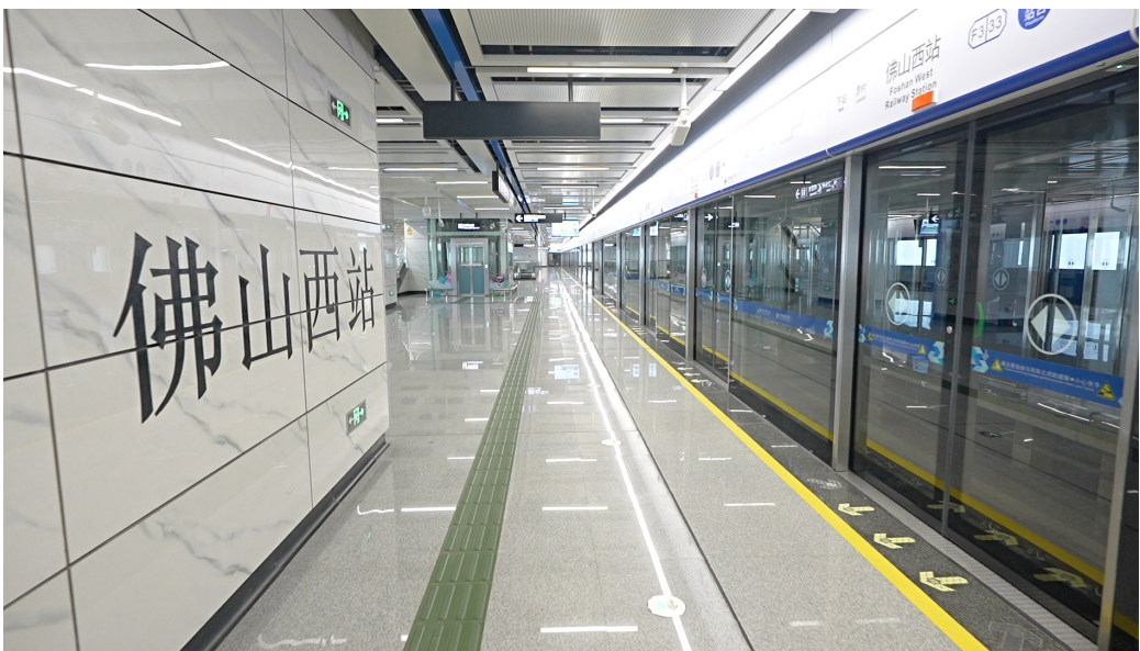
佛山地铁3号线在建段可直达佛山西站。目前站内设施设备已准备就绪。
