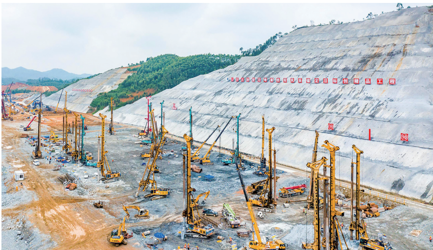
广湛铁路珠三角枢纽机场站站前十四标施工现场,数十台大型施工器械同步作业。 /佛山市新闻传媒中心记者洪海摄
