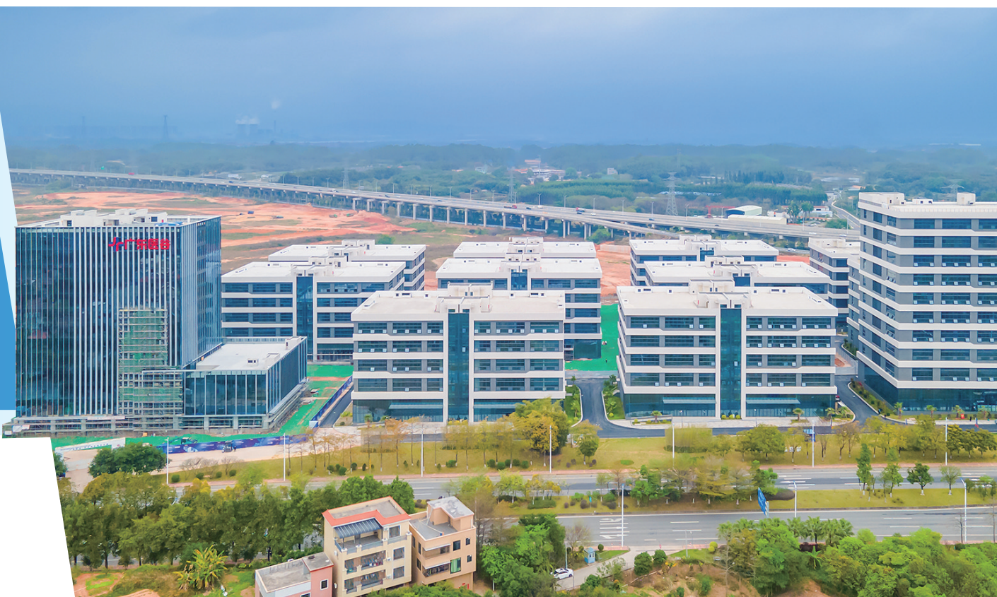
佛山云东海医药健康产业园内，多个项目正加快建设。图为广东医谷·云东海生命科学园项目。
