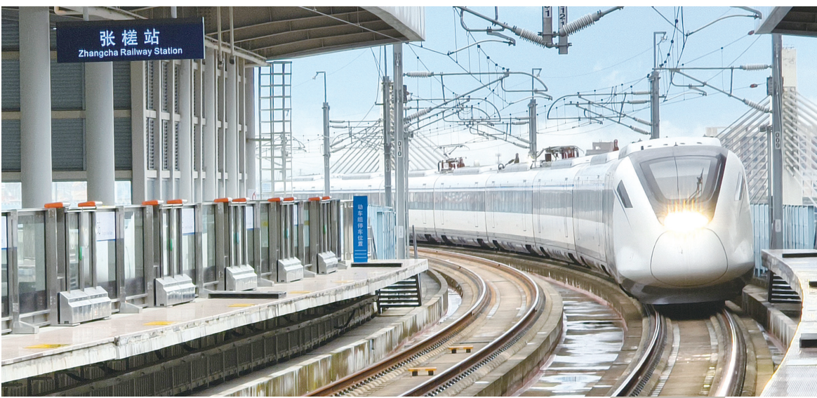
广佛南环张槎站,列车进入站台。/佛山市新闻传媒中心记者何志恒摄
