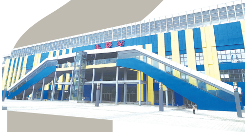
广佛南环张槎站。 /佛山市新闻传媒中心记者任志耀摄
