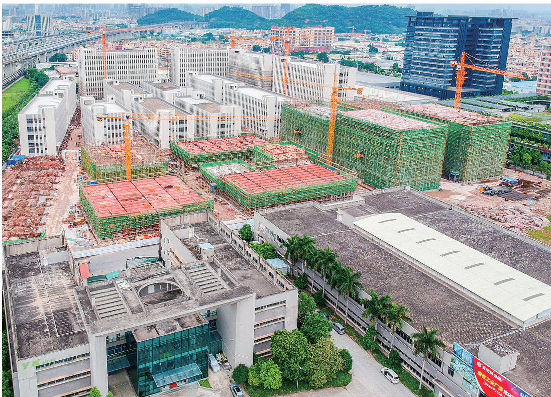
位于三龙湾科技城的宣安科技园。该项目盘活土地资源,提高了土地利用效率。 /佛山日报记者周春摄
