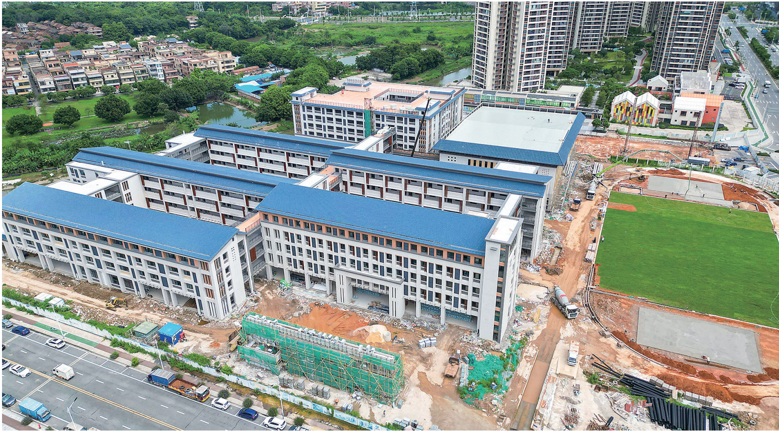
8月30日,三水区新城小学建设工程已接近尾声,正加快室内外装修以及园区绿化、运动场施工等。/ 佛山市新闻传媒中心记者赖基润摄
