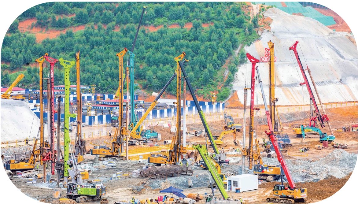
热火朝天的桩基施工现场。
