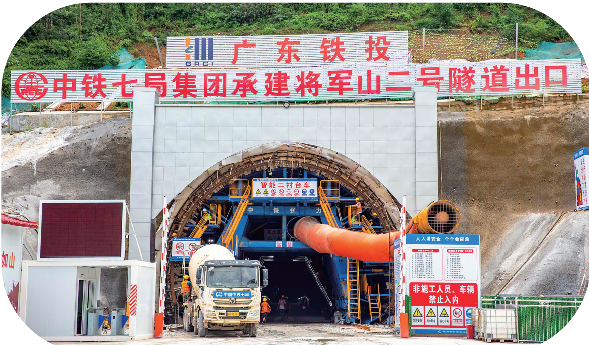
前日,珠肇高铁七标项目将军山二号隧道出口进行首板二衬浇筑。
