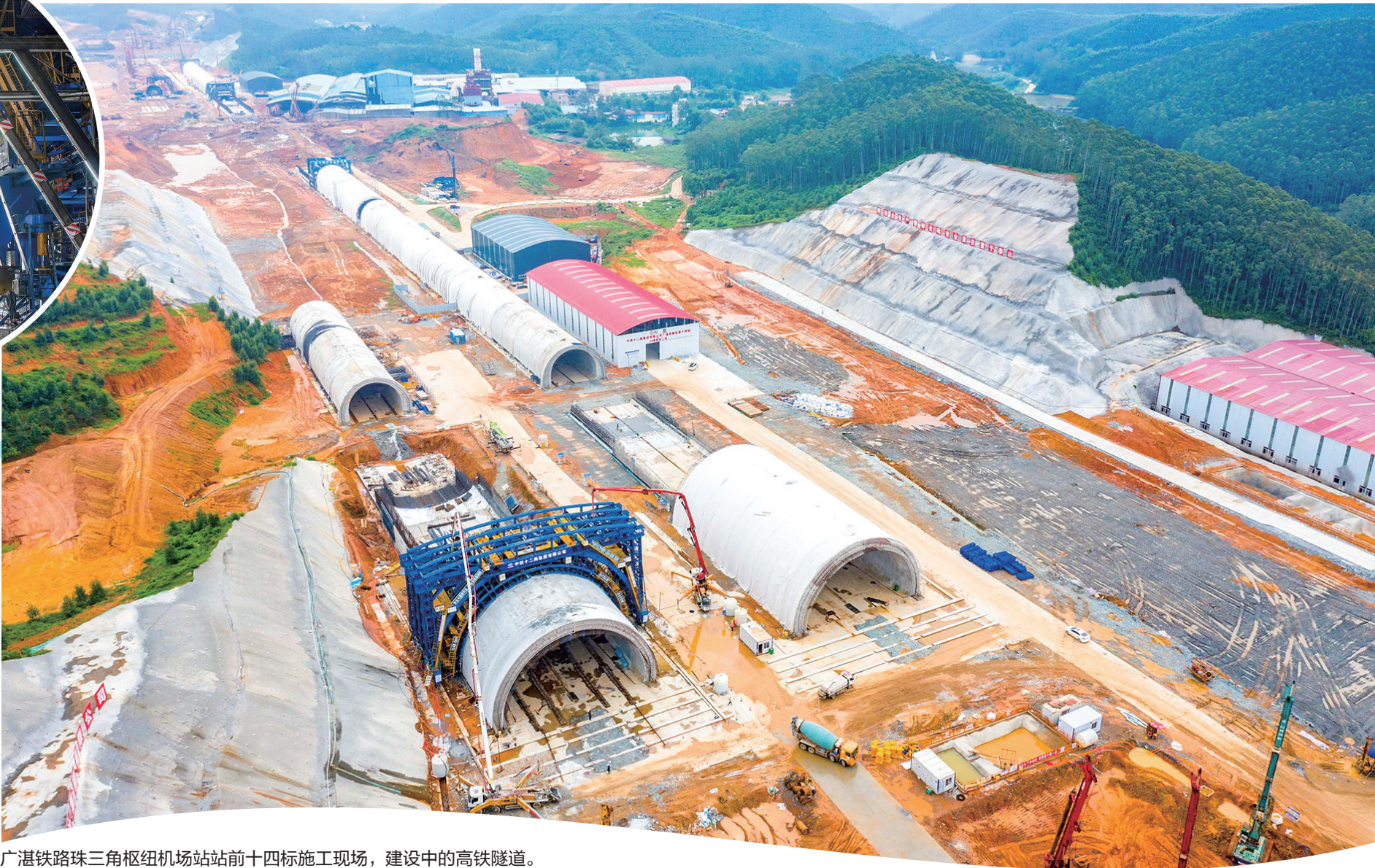
广湛铁路珠三角枢纽机场站站前十四标施工现场，建设中的高铁隧道。
