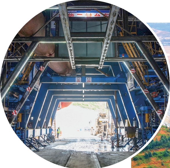
珠肇高铁七标项目将军山二号隧道出口施工现场。
