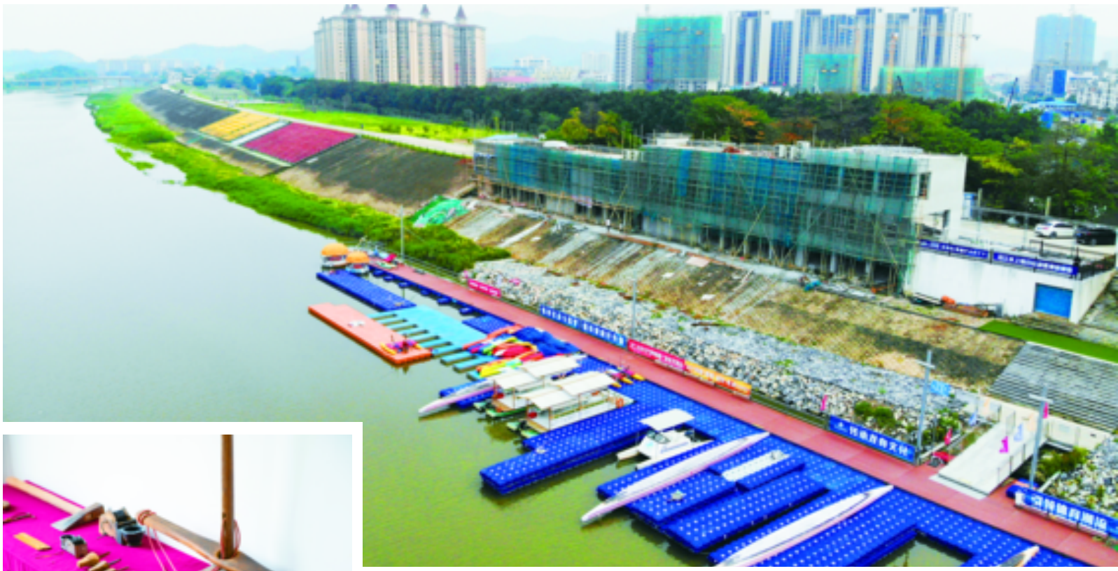
正在建设的沧江龙舟文化博物馆。/图片均为佛山日报记者洪海摄
