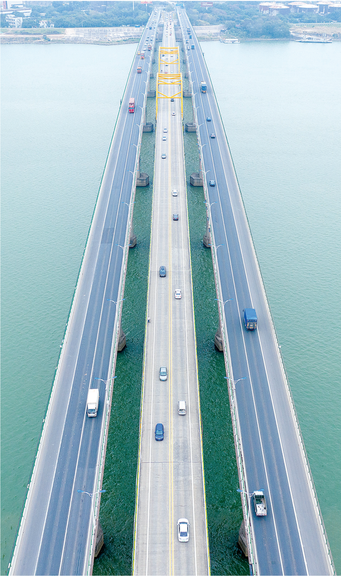
高明大桥现由新桥和旧桥两部分组成，中间为旧桥。
