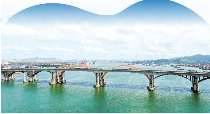
高明大桥曾荣获建设部“中国建设工程鲁班奖”。
