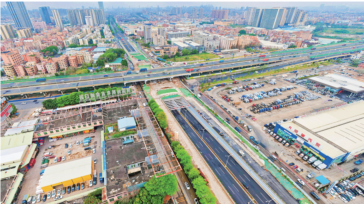
广佛新干线佛山一环隧道主线完工。
